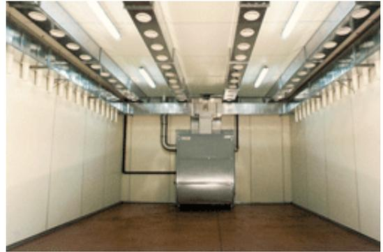
Montage au mur avec unité de condensation externe à la chambre et partie évaporation à l'intérieur de la chambre.
